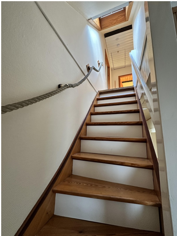
Treppe ins Dachgeschoss
