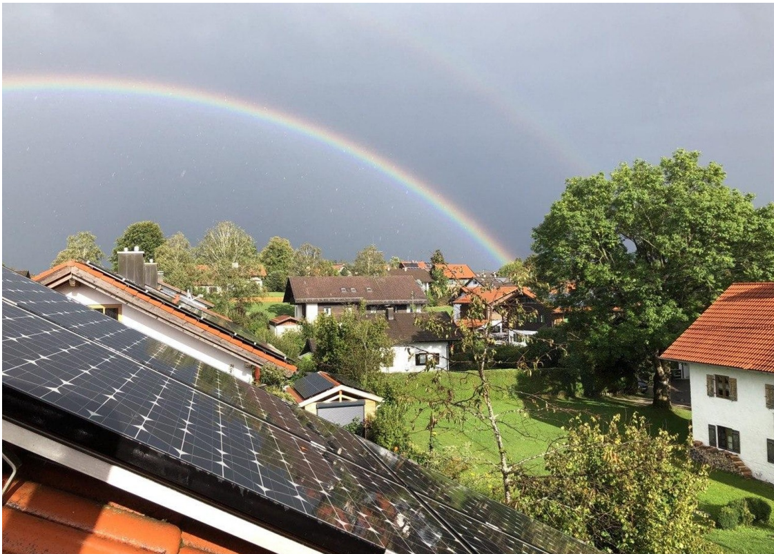
Dach Blick Osten
