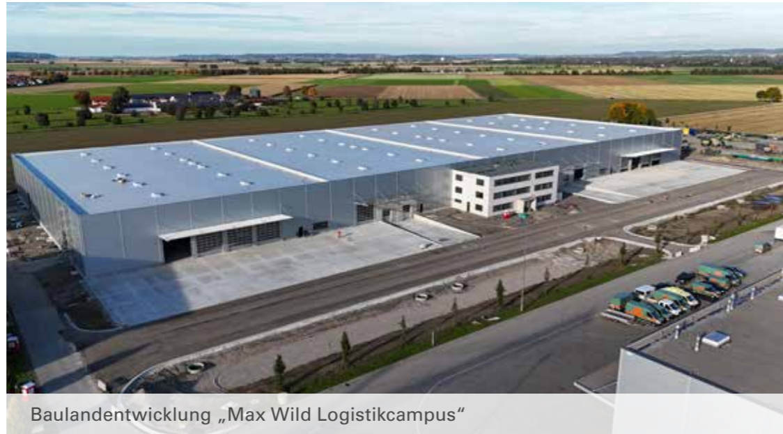
Baulandentwicklung „TRIEBWERK“, am Allgäu-Airport
