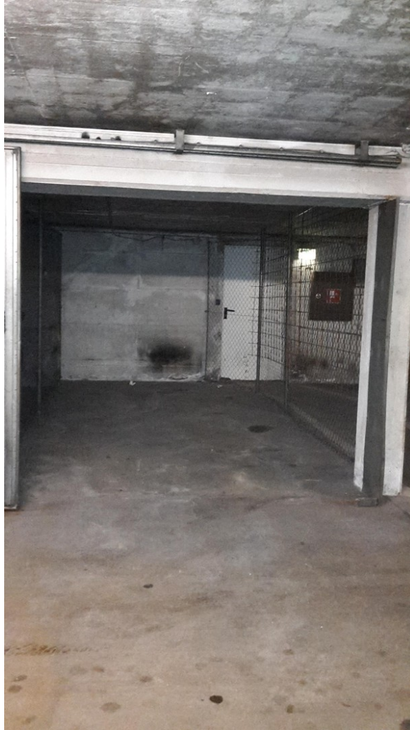
Blick in die Garage
