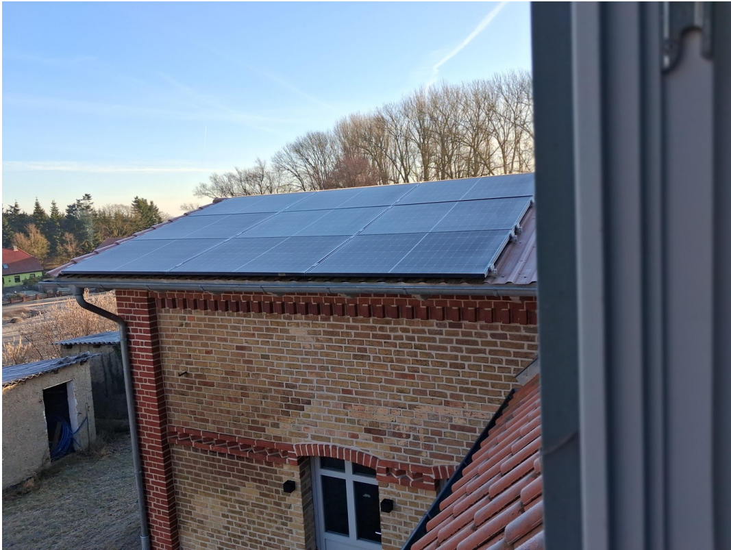
PV-Anlage auf dem Anbau
