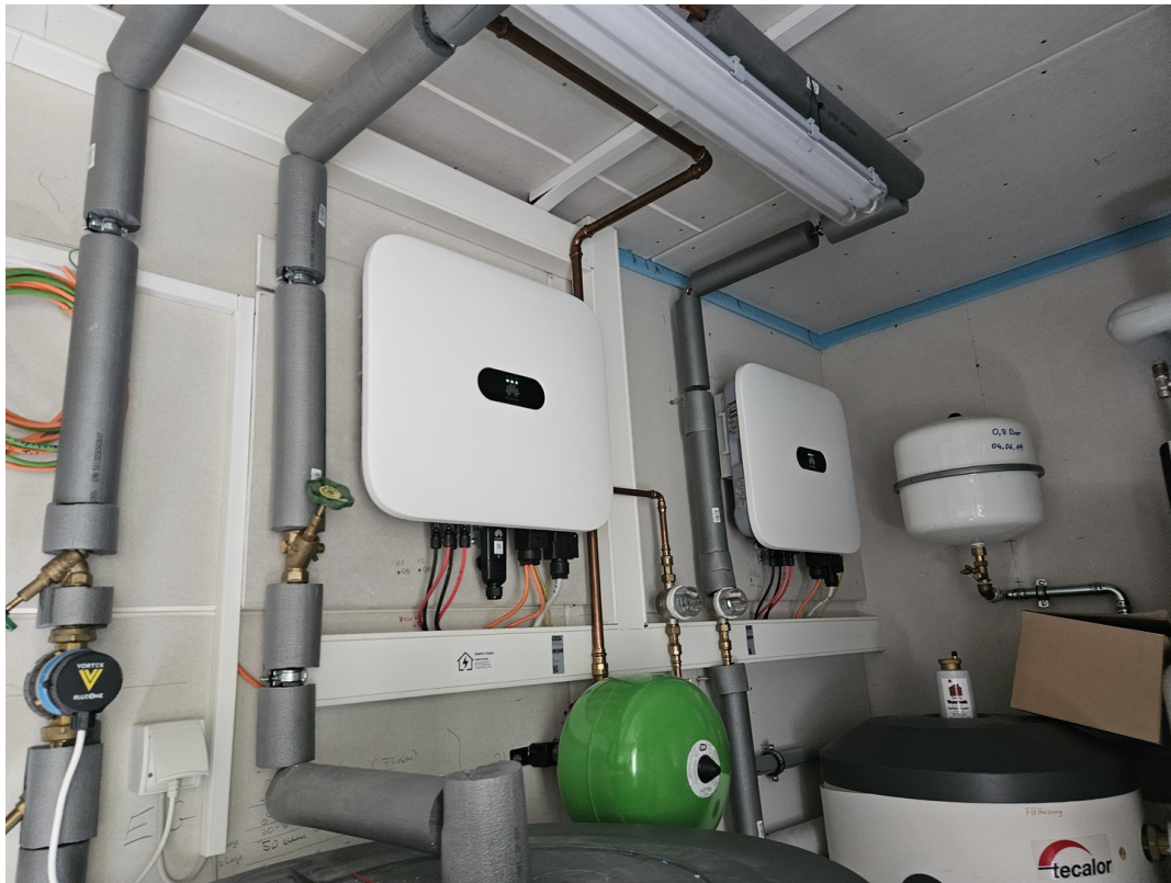
Wechselrichter PV-Anlage
