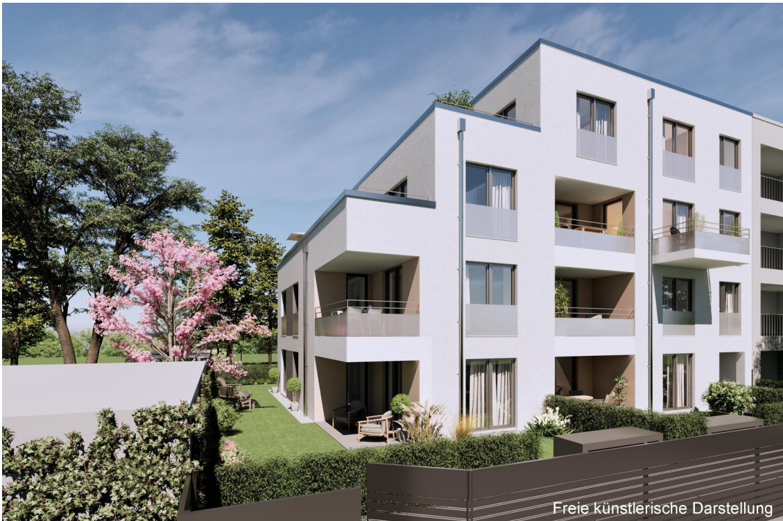
Ansicht vom Südwesten
