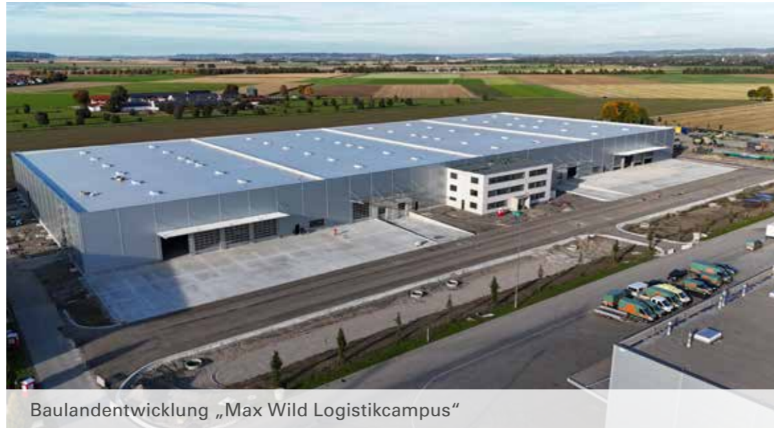
Baulandentwicklung „TRIEBWERK“, am Allgäu-Airport
