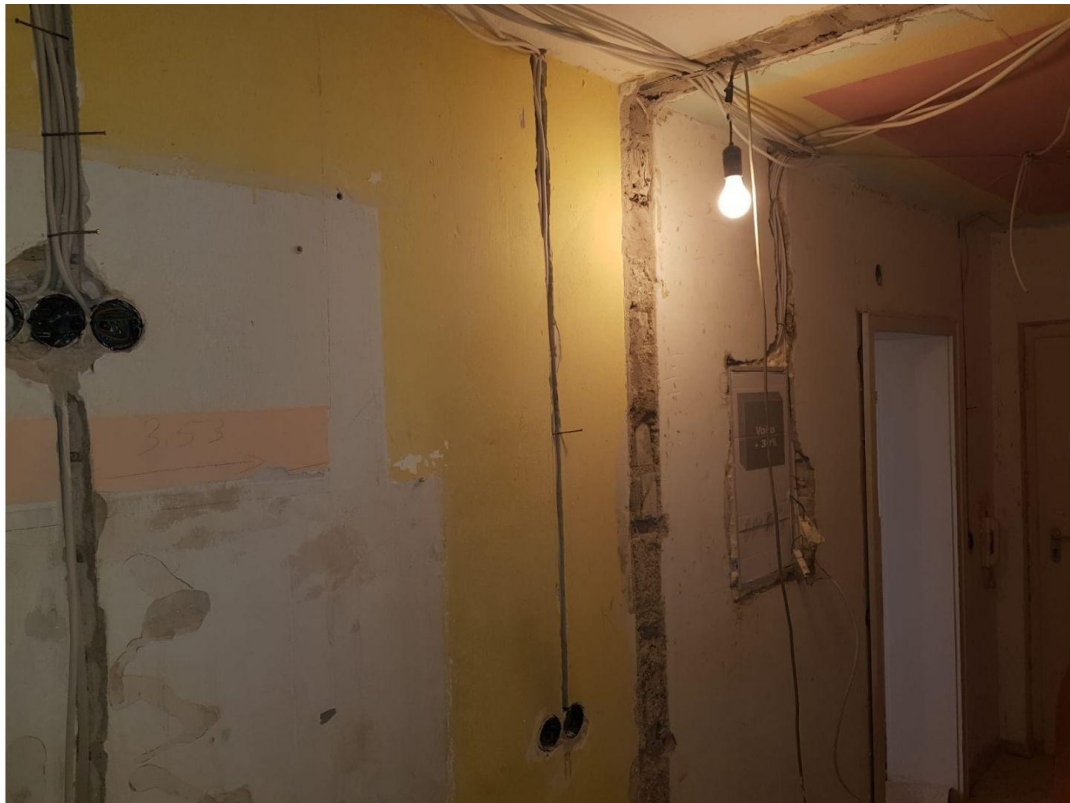
Elektrik auf Neubau-Niveau
