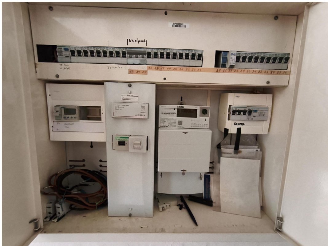
Stromzählerschrank
