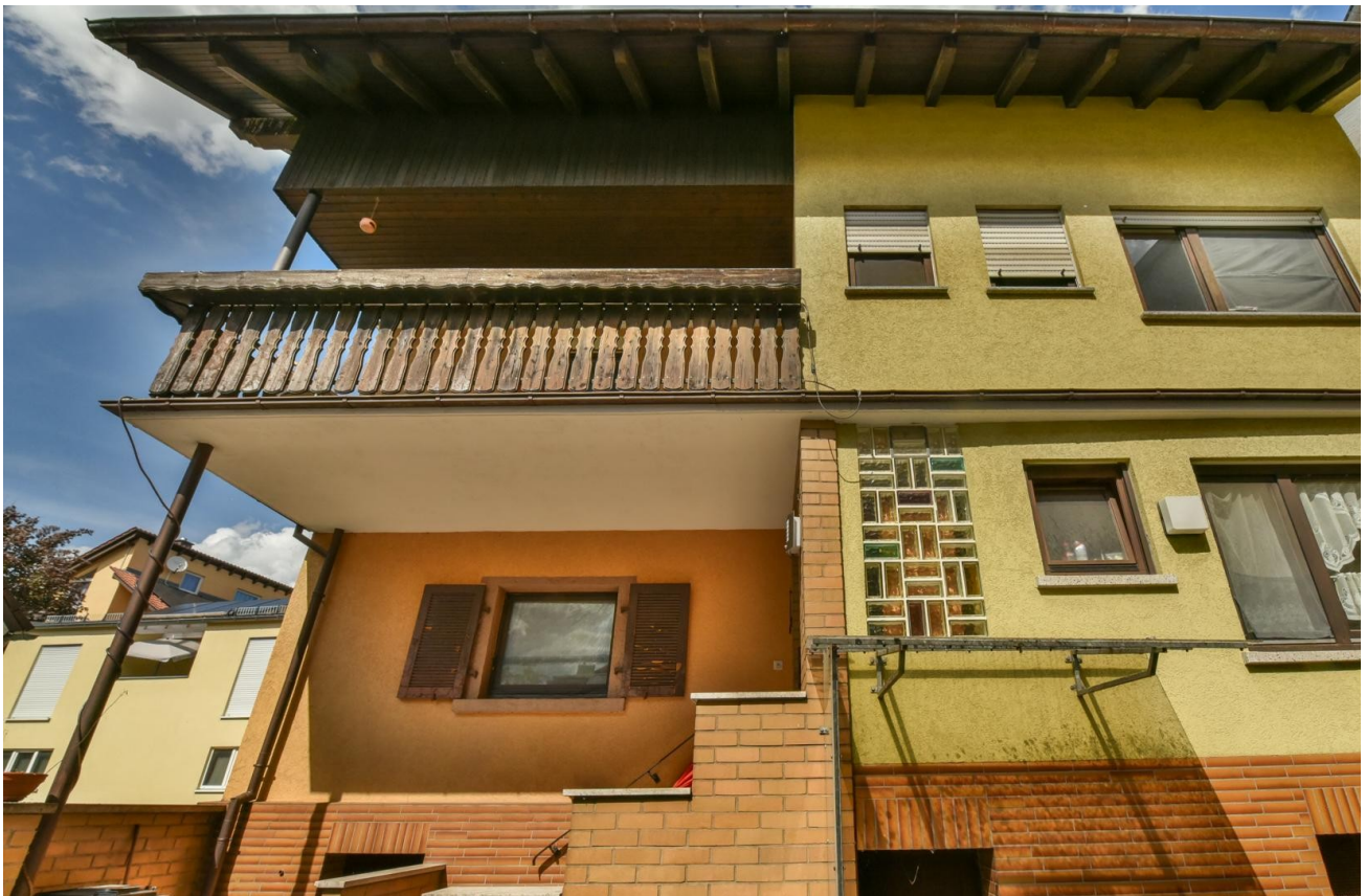
Außenansicht vom Hof aus
