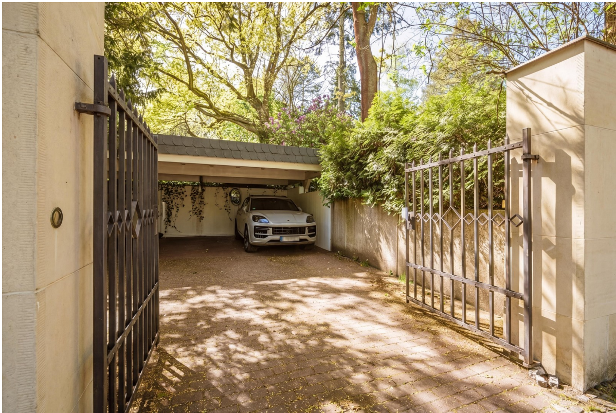
Carport mit E-Ladestation
