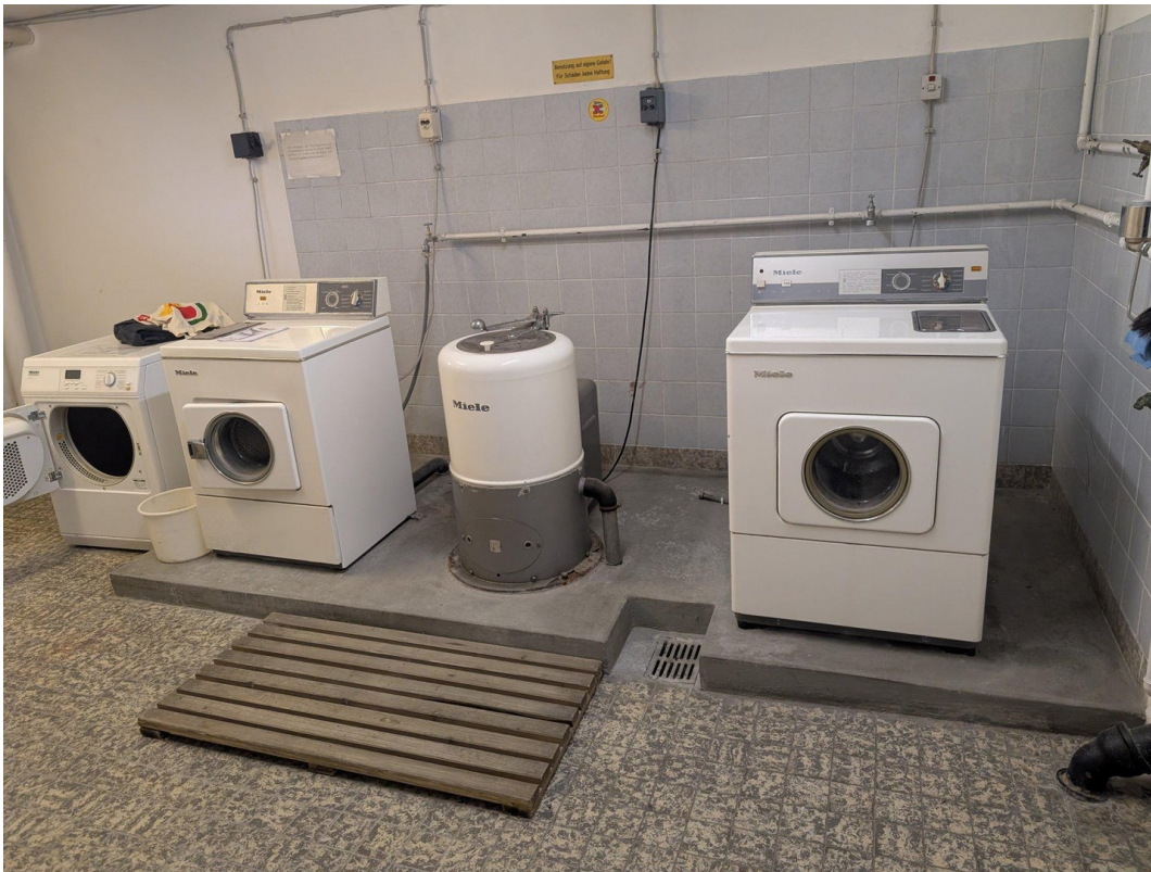
Waschraum im Keller
