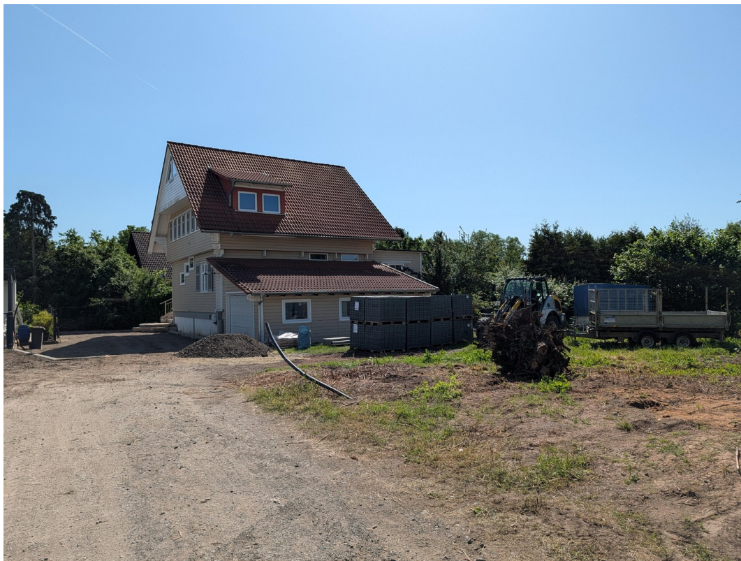
Baustelle Pflasterarbeiten BW6
