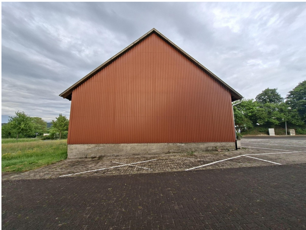
Trapezblechbeplankung Giebel
