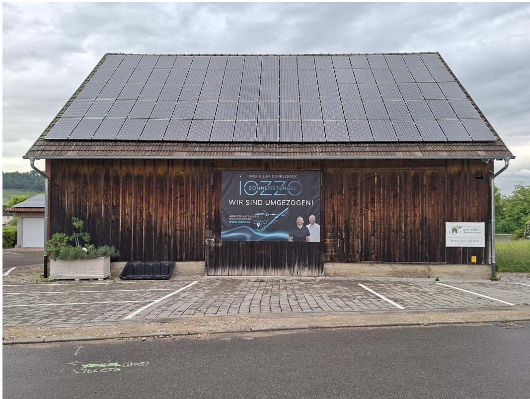
Schiebetor an Zufahrt
