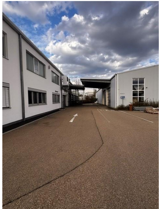
Zwischen den Hallen
