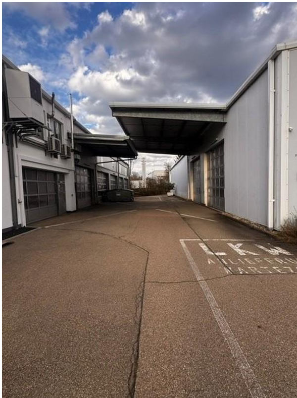
zwischen den Hallen
