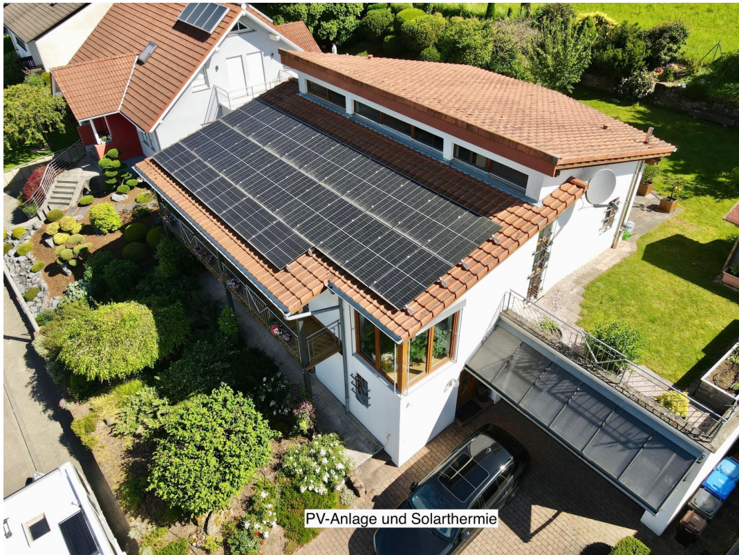
PV-Anlage und Solarthermie
