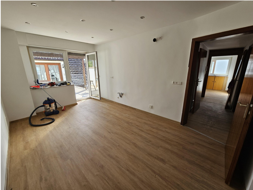
Küche mit Terasse
