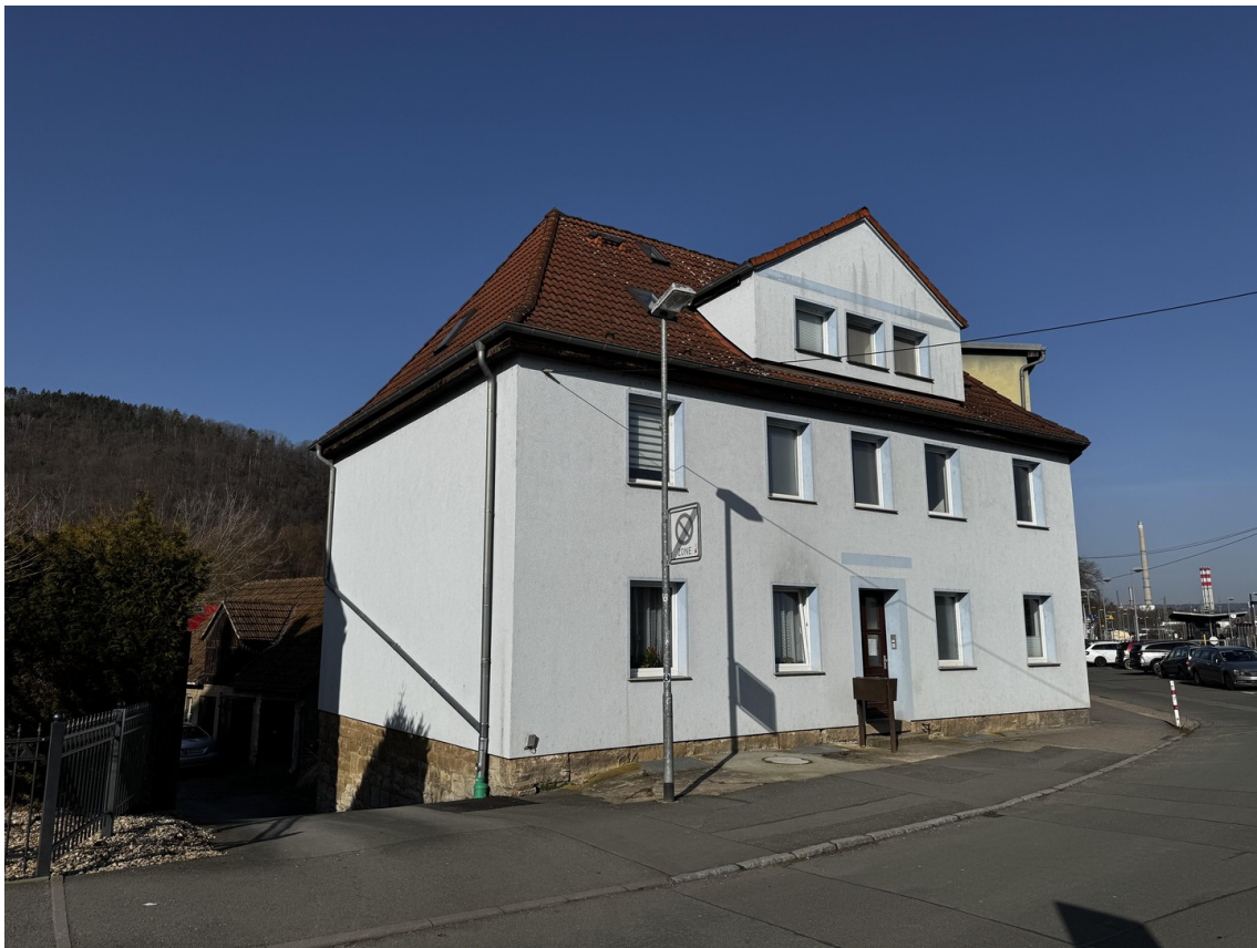
Haus von außen
