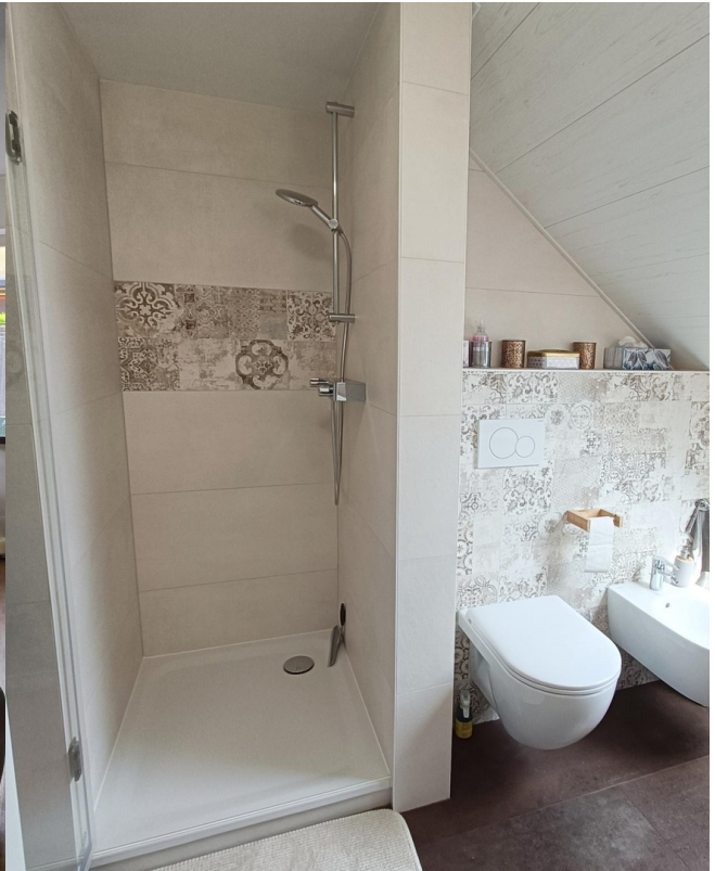
Duschbad DG mit WC und Bidet
