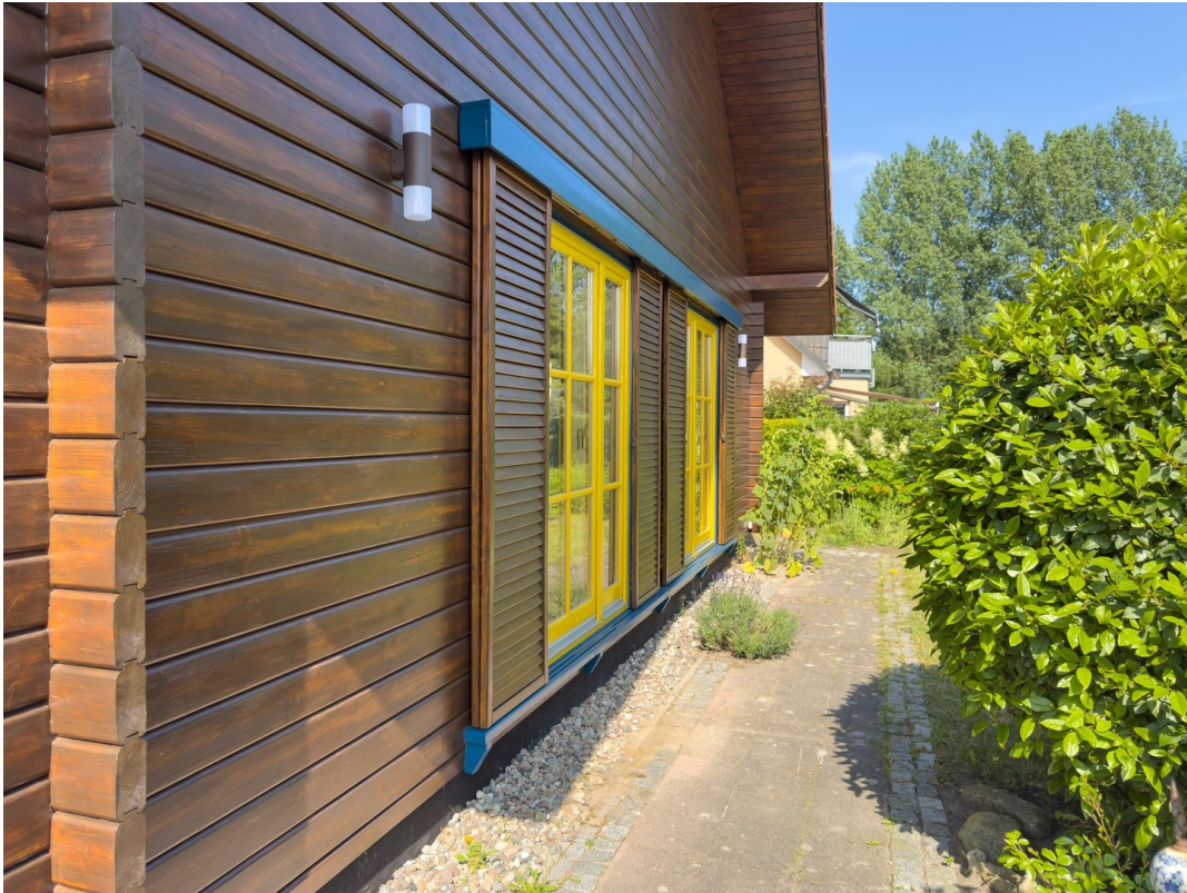
Südseite mit Fensterläden
