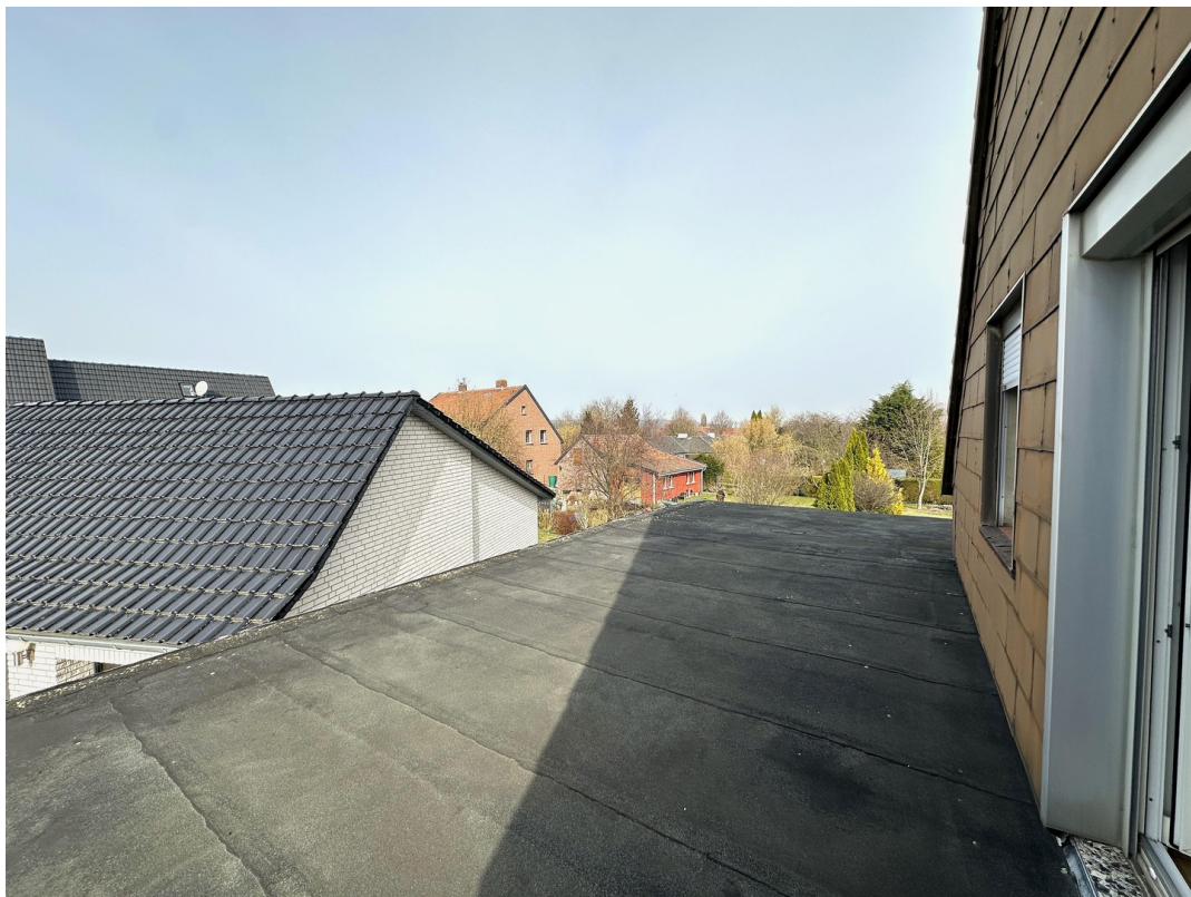
OG Dachterrasse nicht ausgebaut
