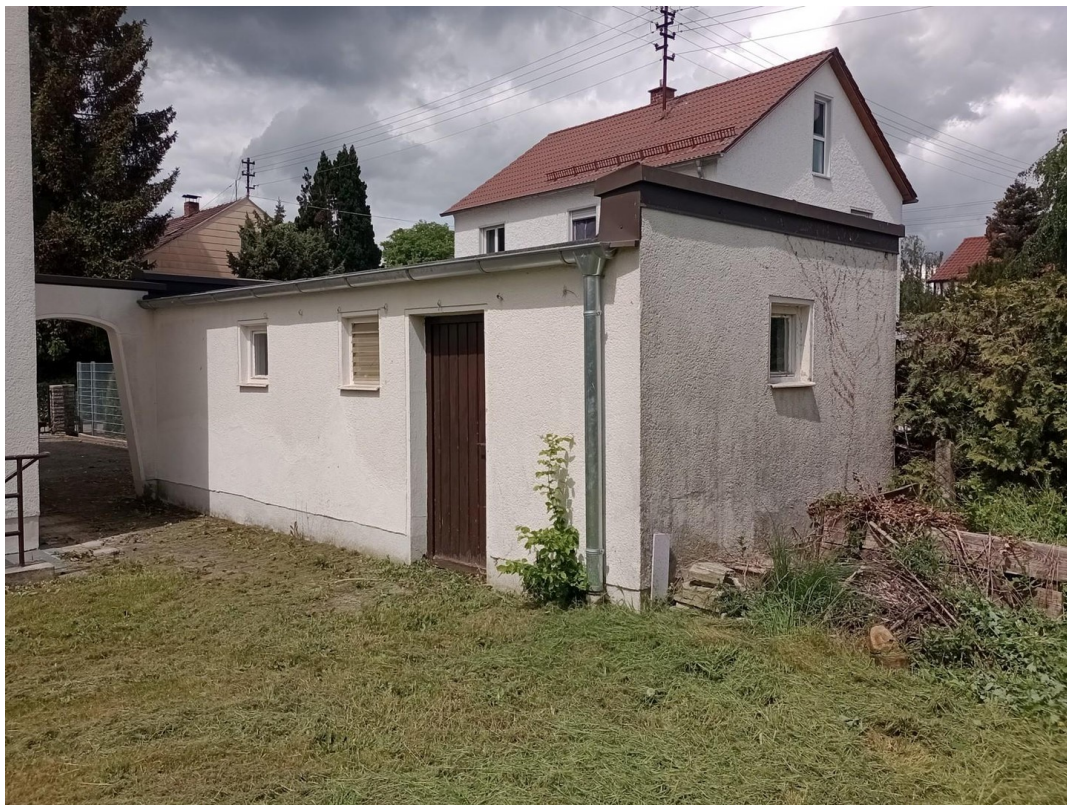
Geräteraum hinter Garage
