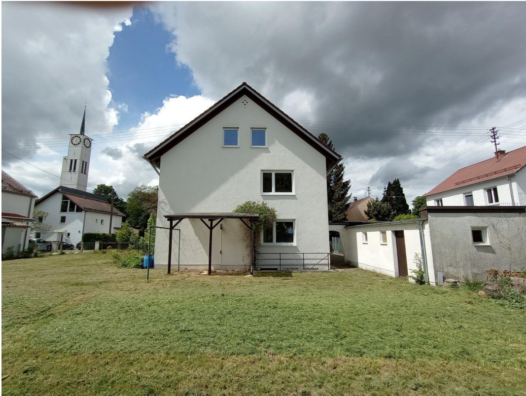
Ostansicht mit überdachter Ter
