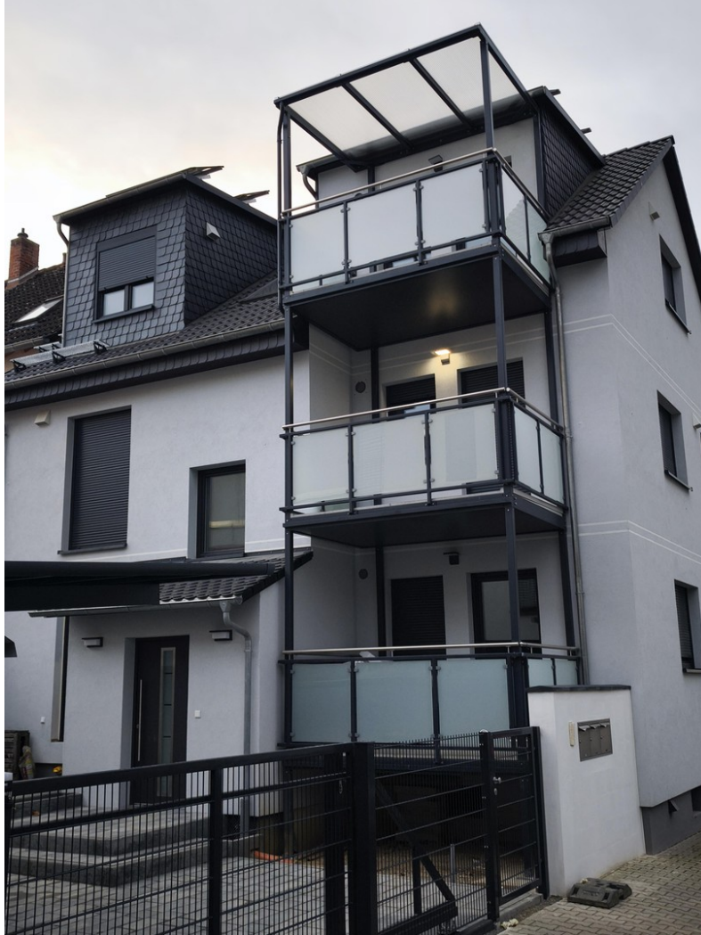
Hofansicht mit Balkonanlage
