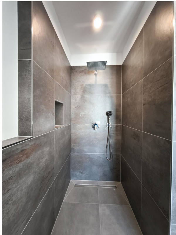
mit bodengleicher Dusche
