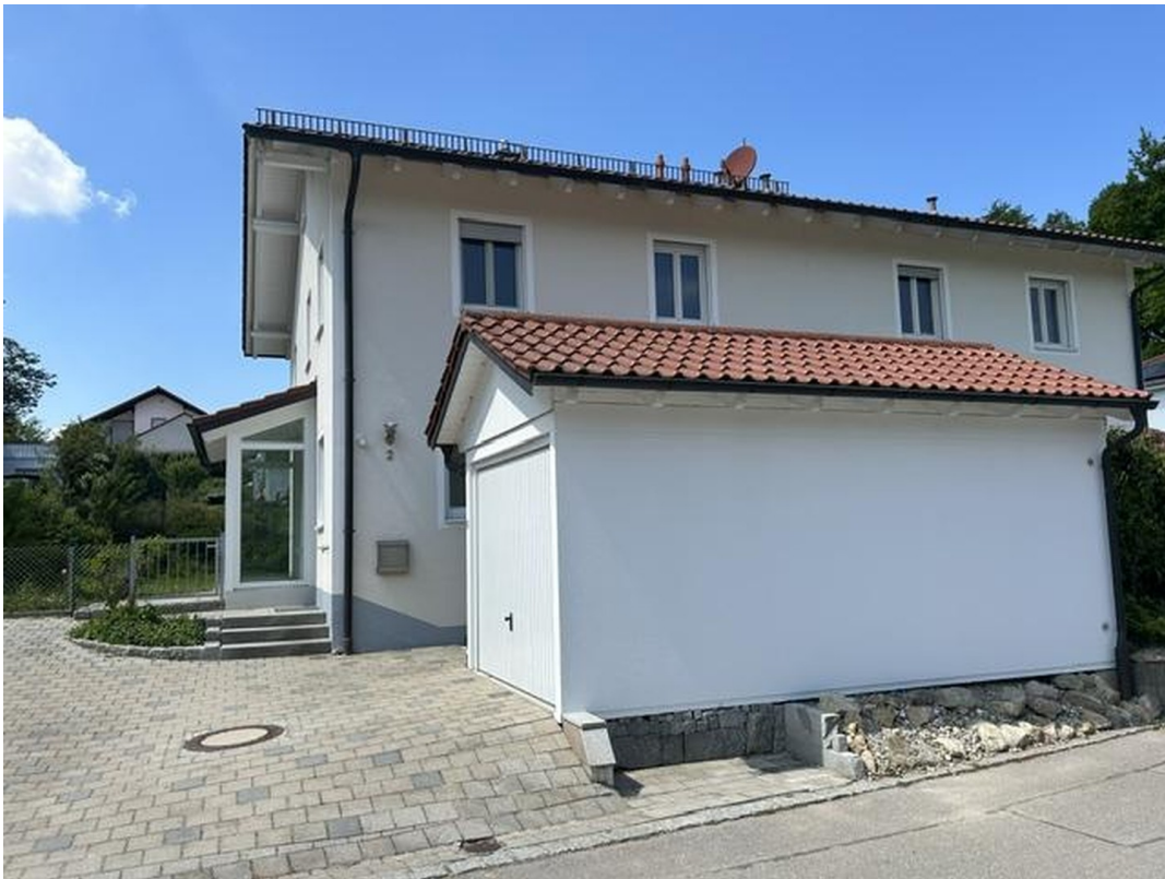
Brunnenstr.2 Zufahrt Garage
