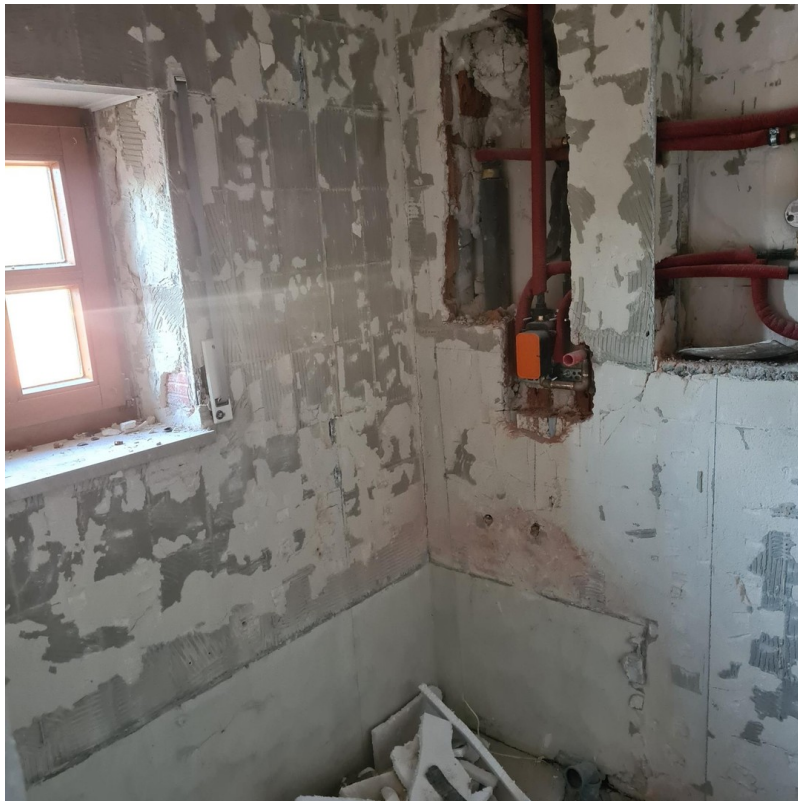
Kernsanierung Wasser Bad 2025
