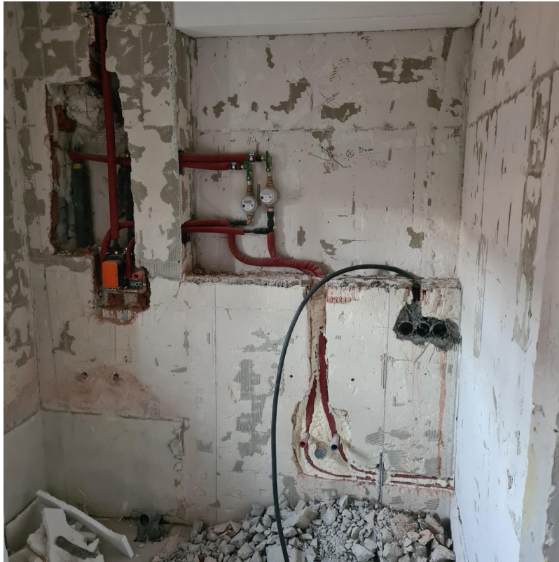
Kernsanierung Wasser Bad 2025
