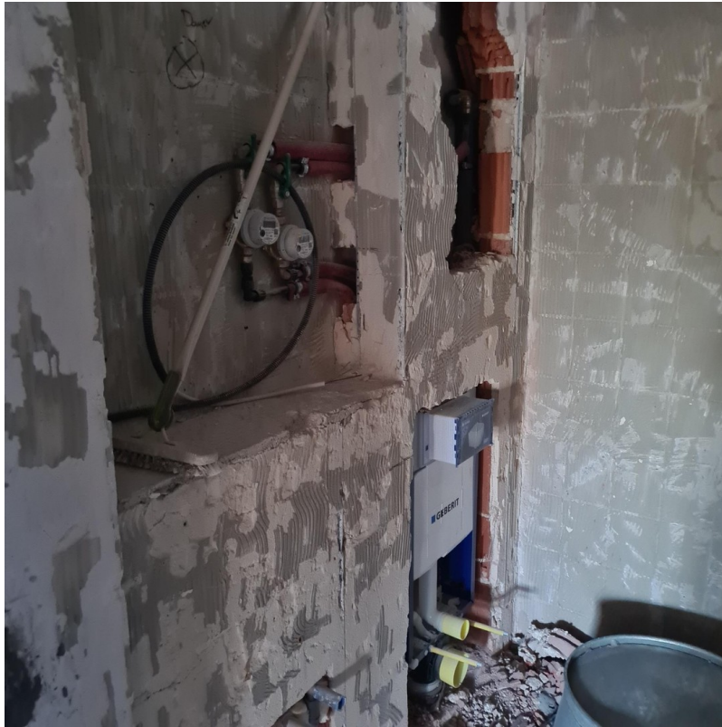
Kernsanierung Wasser WC 2025
