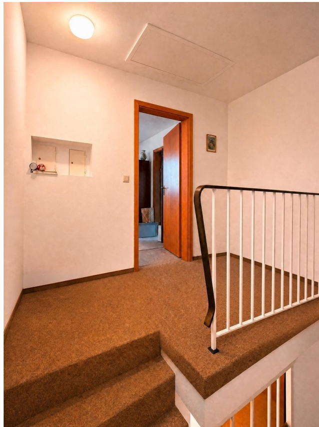
Flur und Zugang Spitzdach OG
