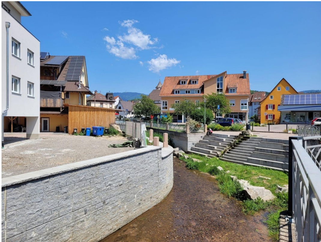
Treppe zur Kander
