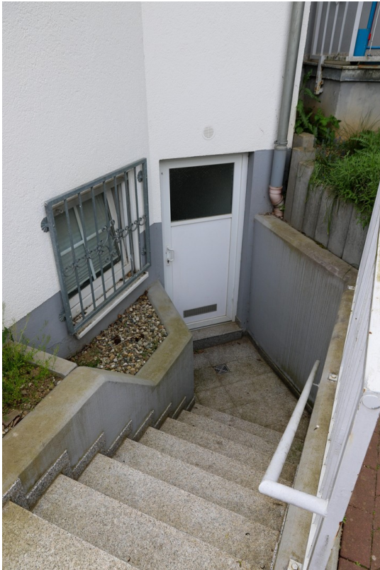
Treppenabgang zum Keller
