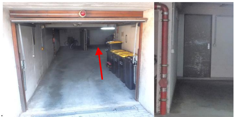
TG-Stellplatz mit direkt angrenzender Brandschutz-Kellertür:
