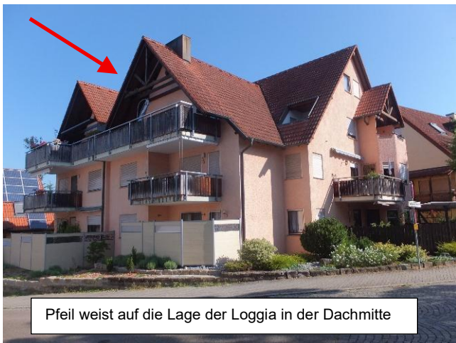
Straßenansicht Gebäude (Eck-Grundstück):
