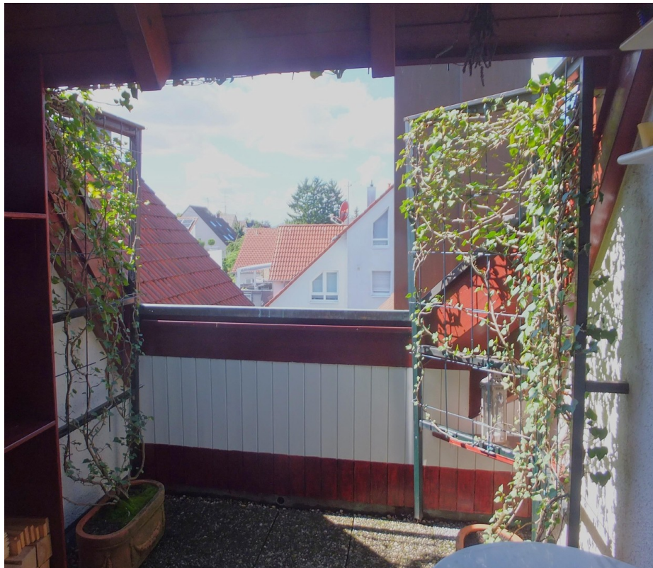
Dach-Loggia DG II
