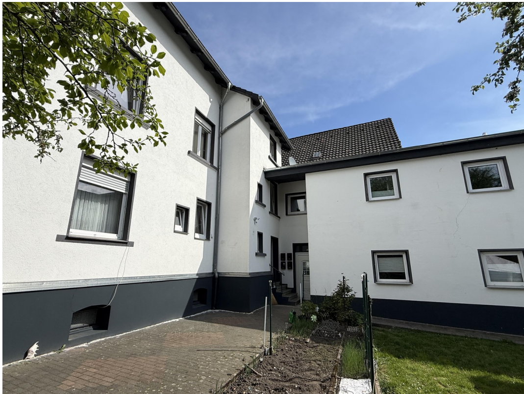
Außenansicht Haupthaus & Anbau
