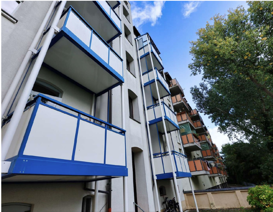
Innenhoffassade mit Balkonen
