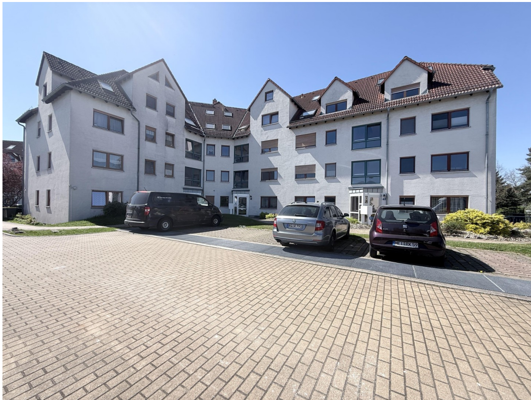
Blick vom Innenhof
