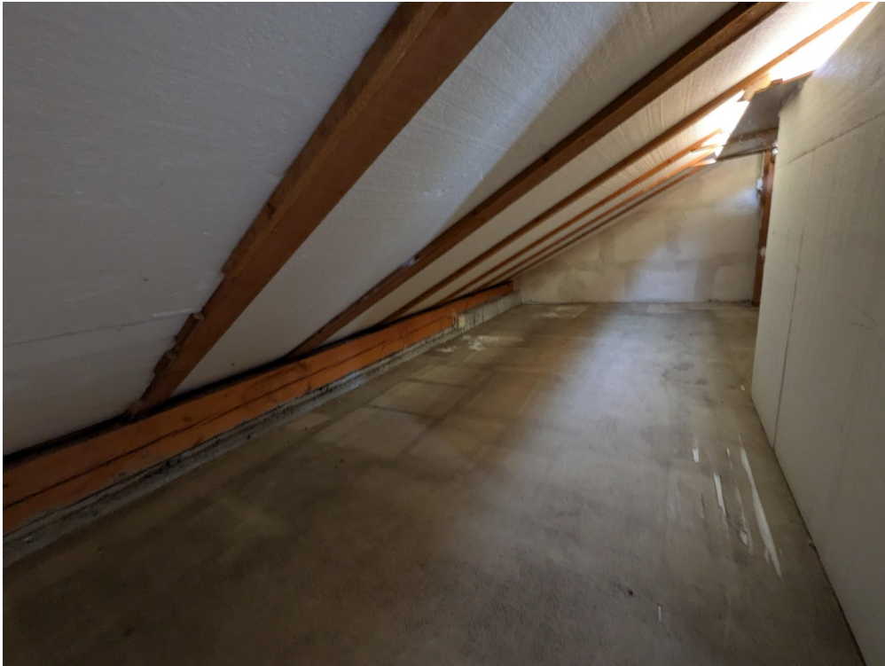
Abstellfläche Nebenraum Bühne
