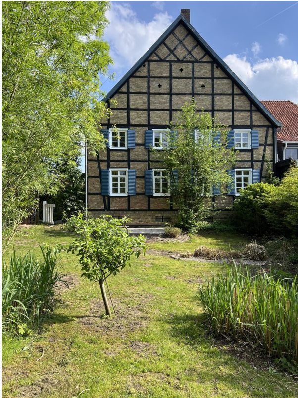
Außenfassade Nord und Garten
