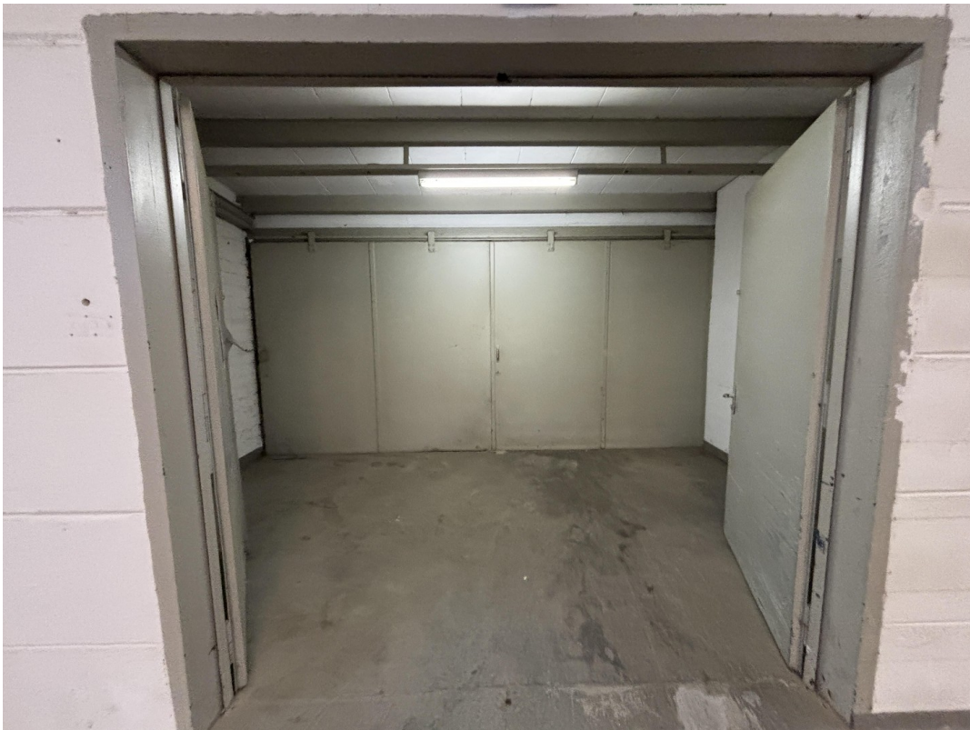
Vorraum zur Rampe
