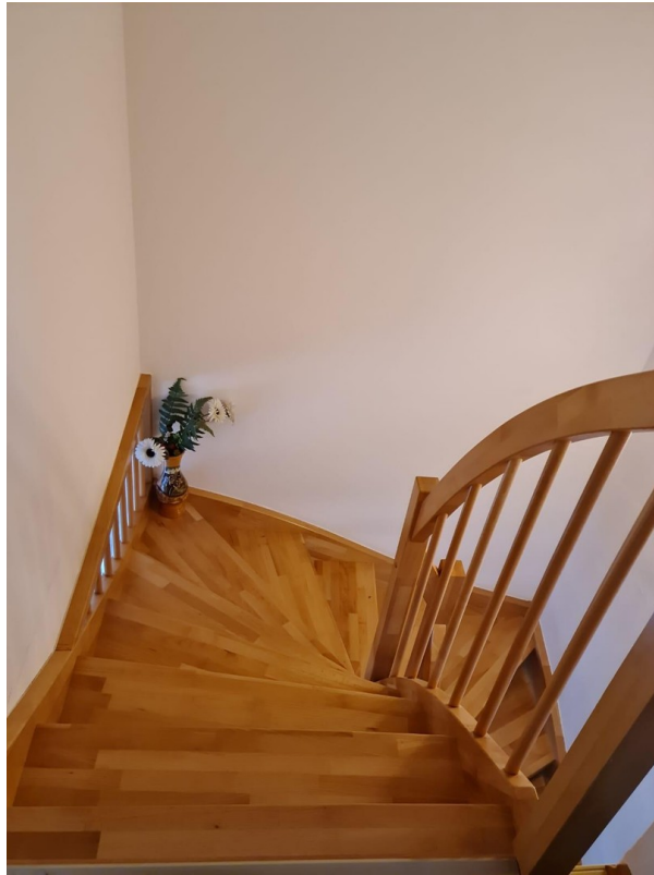
Treppe zum 2. OG
