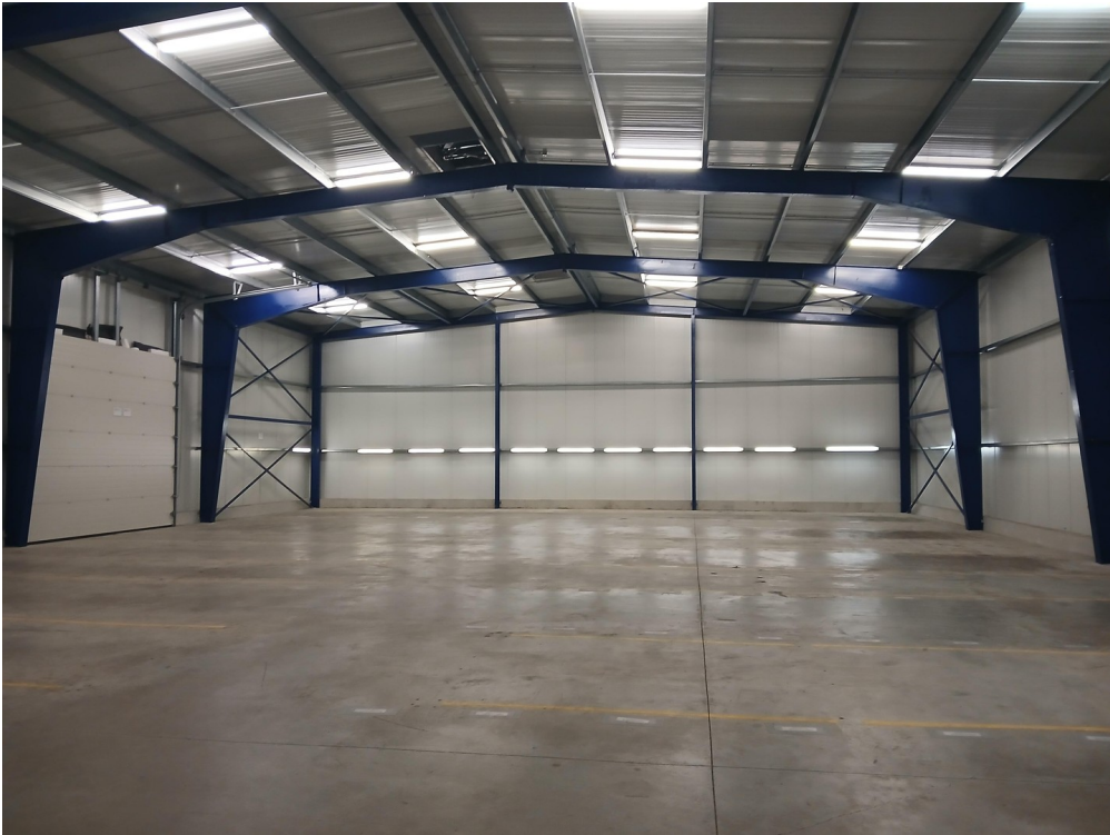
Stützenfrei Boden geschliffen
