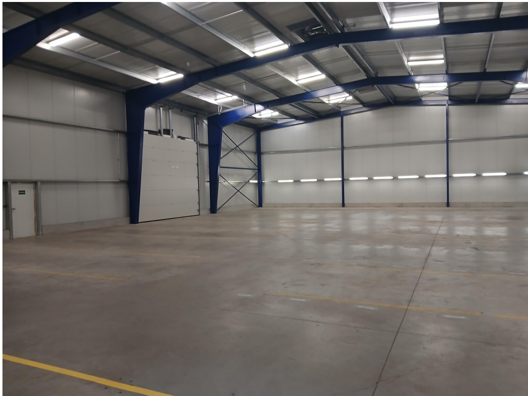
Hochregallager höhe 7 Meter
