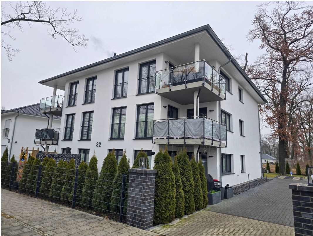
Haus von außen
