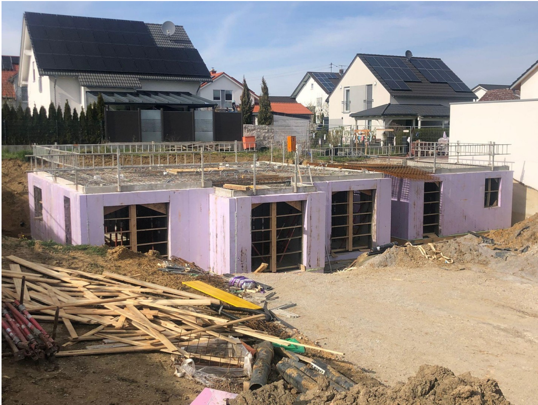
Ansicht Südseite Wohnkeller
