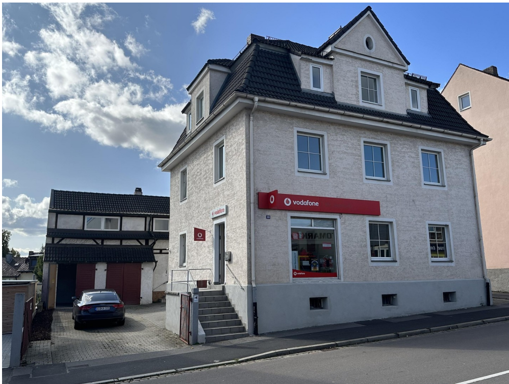
Fassade Eingang Vodafone Shop
