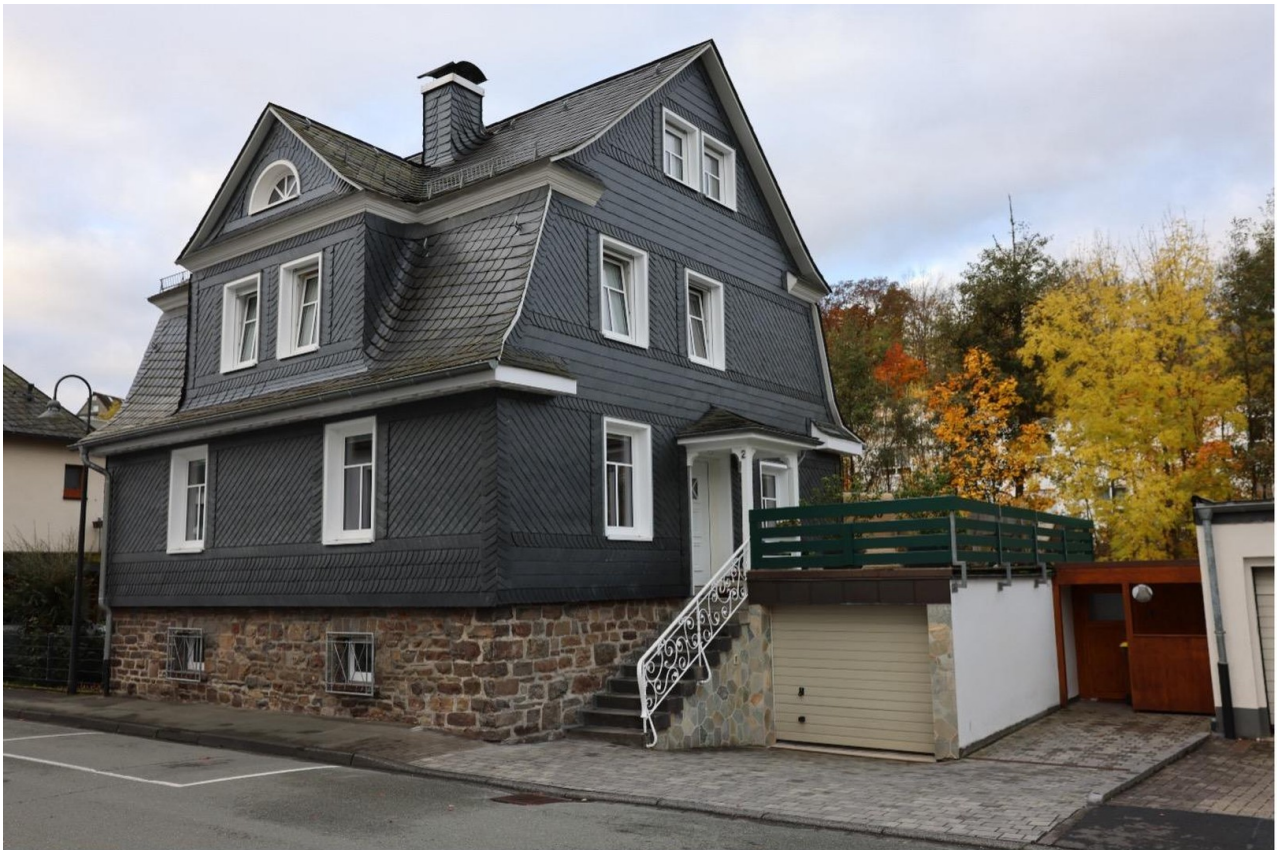
Ost Ansicht Haus
