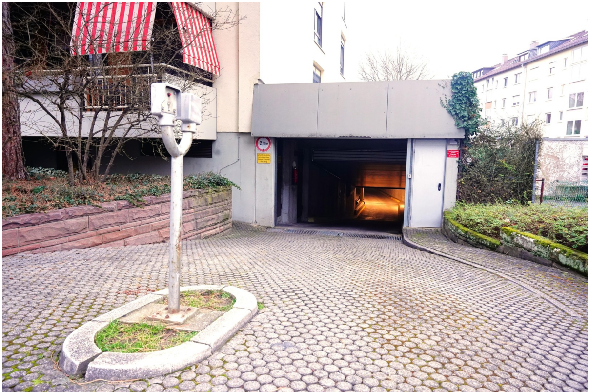
Tiefgarage von Straßenseite
