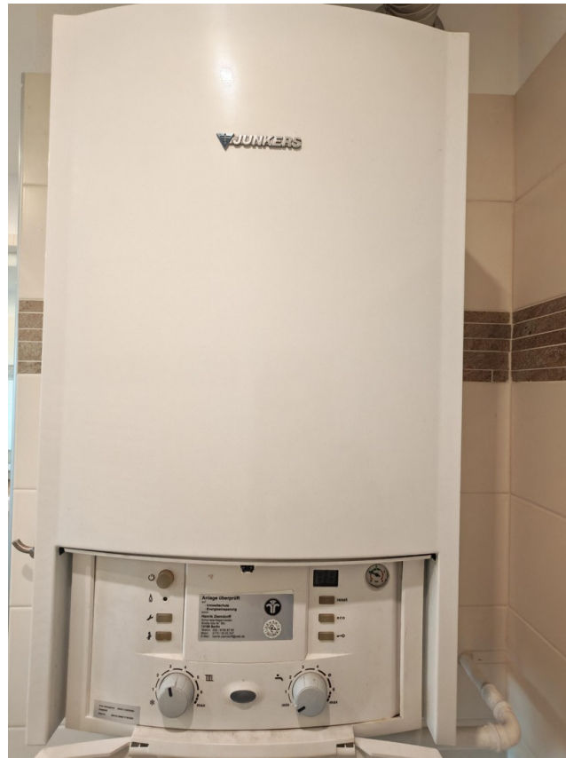
Gasetagenheizung
