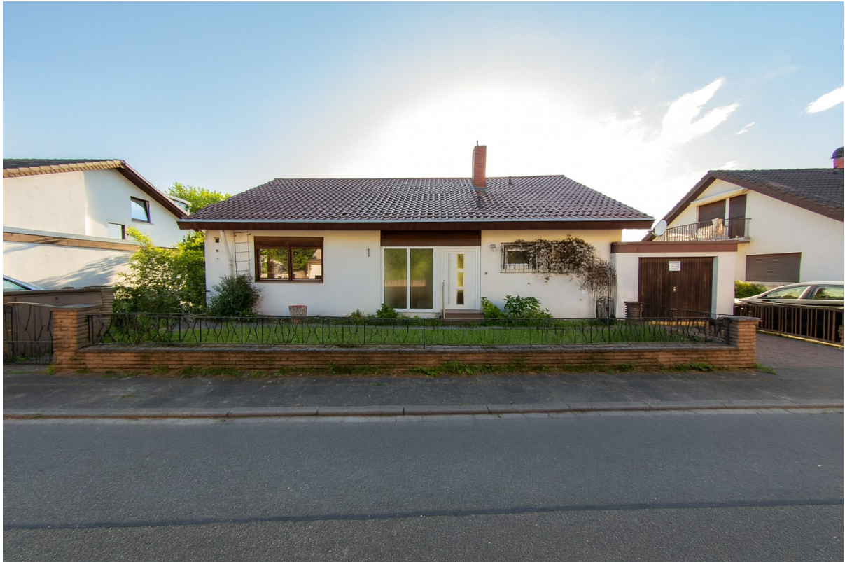
Straßenansicht des Hauses
