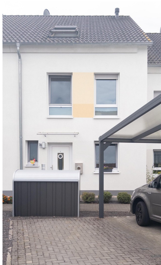
Ansicht von der Strasse
