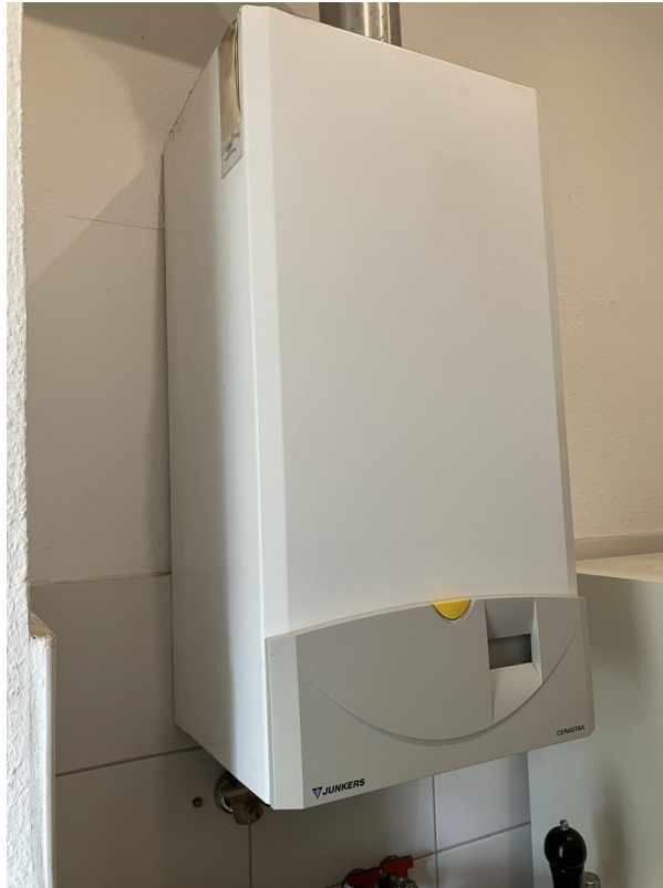
Gasetagenheizung
