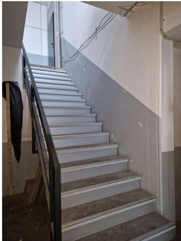
Eingang z. 1 OG
