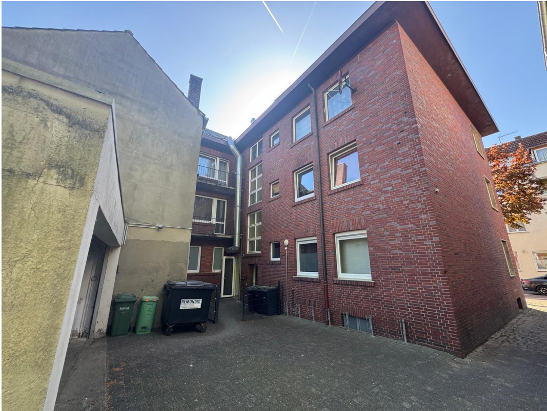
Hof und Ansicht von hinten
