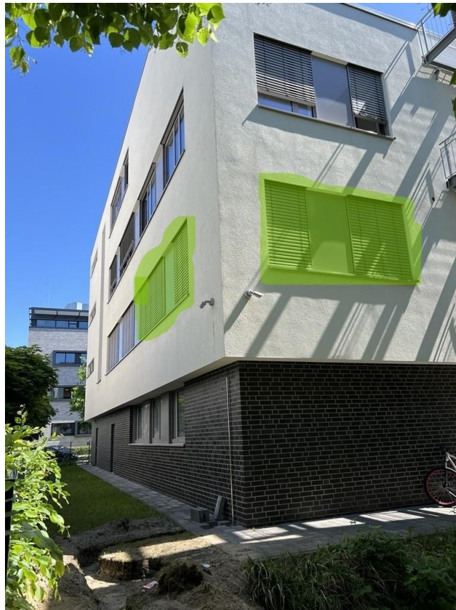
Rückseite vom Gebäude
